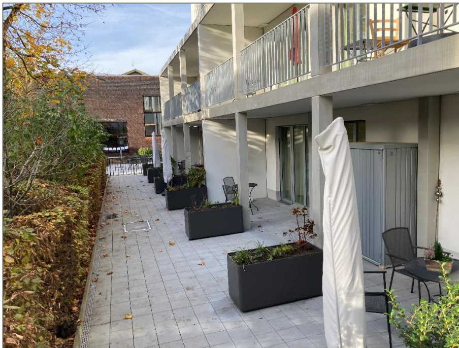
Pflanztröge auf der Terrasse im Erdgeschoss
